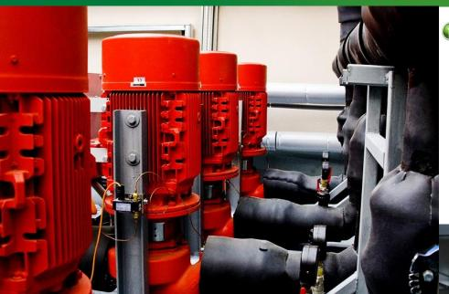
Автоматизированные насосные группы обеспечивают требуемое в данный момент давление в системе.
