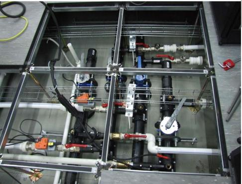
Все трубопроводы оснащены автоматизированной запорной аппаратурой и датчиками протечки.
